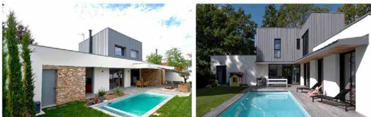
Pierre, zinc et maçonnerie+enduit traditionnel Construction d'une maison individuelle à Cholet
