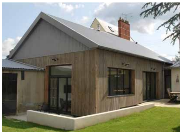
Toiture à deux pentes en bacs-acier gris clair – interprétation contemporaine du volume d'une annexe rurale
