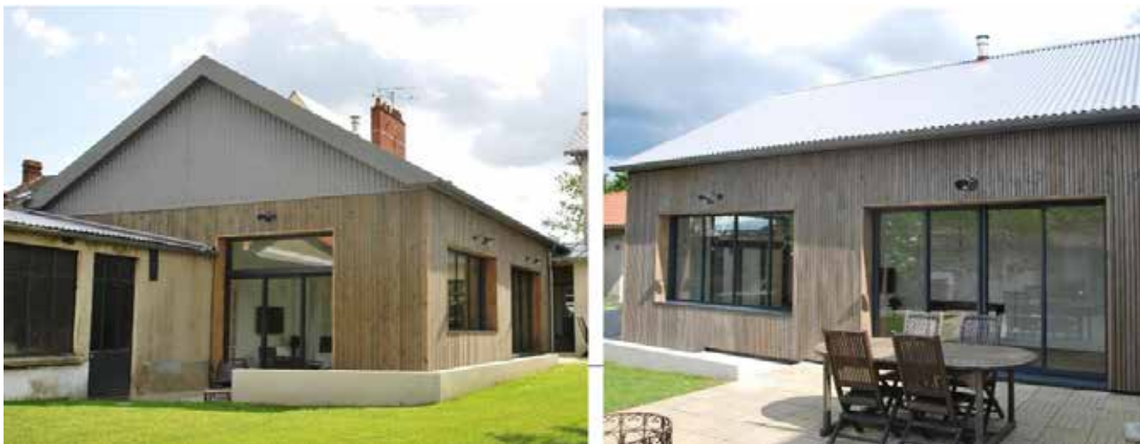
Image et matériaux contemporains pour un volume traditionnel en simple rez-de-chaussée et couverture à deux pentes – Extension de maison individuelle
