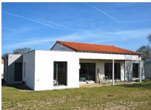
Toiture à deux pentes en tuiles de terre cuite ton rouge Construction d'une maison individuelle à Yzernay
