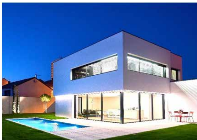
Construction très compacte sur deux niveaux – Volume en toiture terrasse
