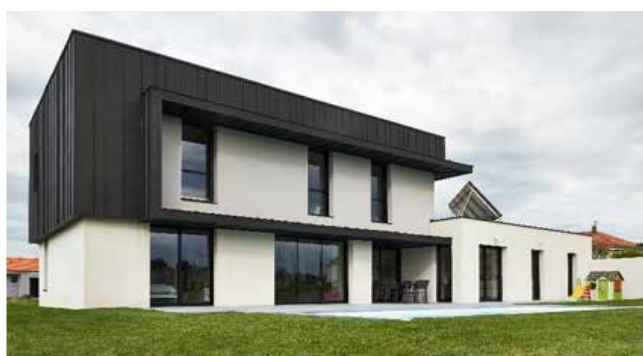
Zinc et maçonnerie+enduit traditionnel Construction d'une maison individuelle à La Verrie
