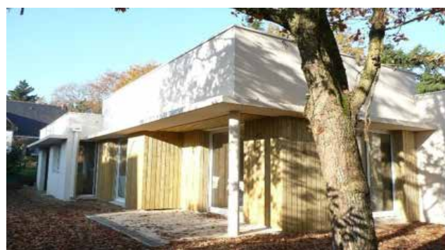
Bois et maçonnerie+enduit traditionnel Construction d'une maison individuelle à Mûrs-Erigné
