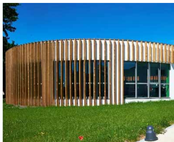
Bardage bois naturel à claire-voie devant un enduit peint
