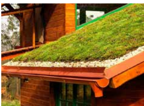
Exemples de toiture terrasse végétalisée
