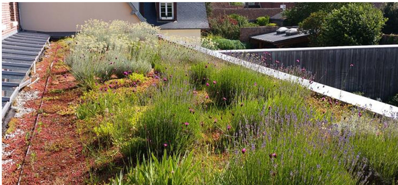
Exemples de toiture terrasse végétalisée
