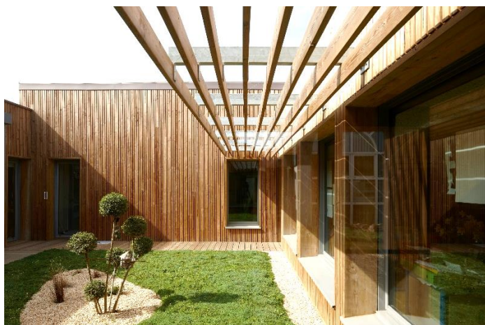
Bardage bois naturel vertical et pergola brise-soleil bois
