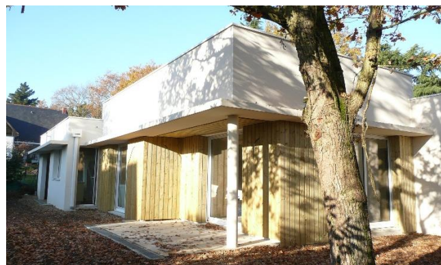
Bois et maçonnerie+enduit traditionnel Construction d'une maison individuelle à Mûrs-Erigné Agence Grégoire Architectes
