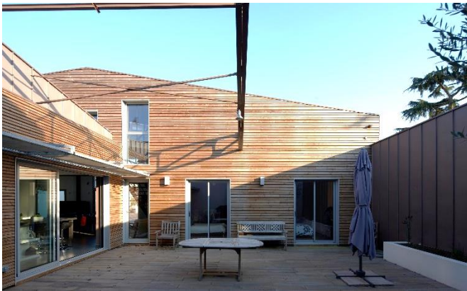
Bois et zinc – Loft à Cholet Agence Grégoire Architectes
