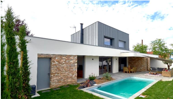
Pierre, zinc et maçonnerie+enduit traditionnel Construction d'une maison individuelle à Cholet Agence Grégoire Architectes
