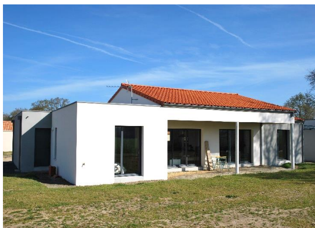
Toiture à deux pentes en tuiles de terre cuite ton rouge Construction d'une maison individuelle à Yzernay Agence Grégoire Architectes
