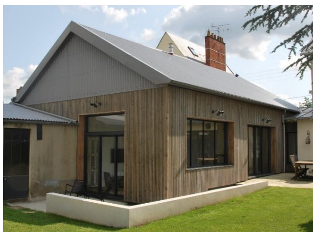
Toiture à deux pentes en bacs-acier gris clair – interprétation contemporaine du volume d'une annexe rurale – extension d'une maison individuelle à Cholet – Agence Grégoire Architectes
