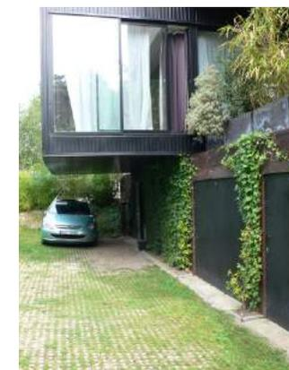
*Maison sur pilotis, respectant la pente et l'écoulement des eaux, réduisant l'imperméabilisation du terrain.*
