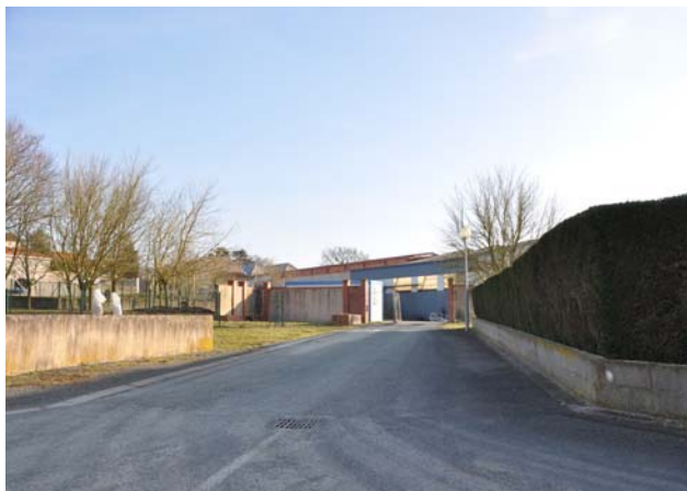
Ancienne usine IX Manu à Evrunes avant déconstruction
